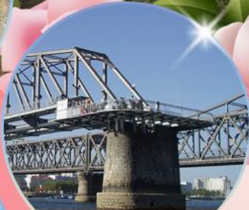
สะพานขาดตานตง
